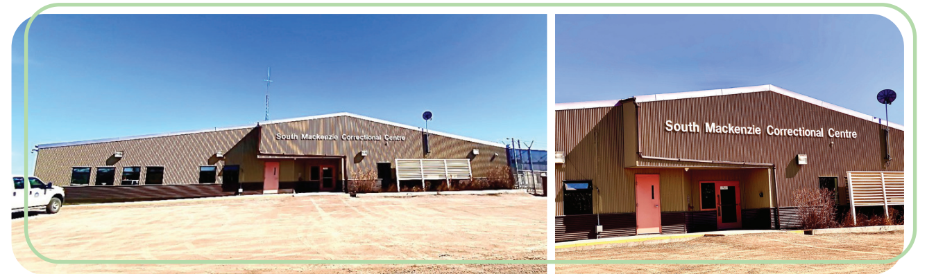
Centre correctionnel du Mackenzie Sud (CCMS) à Hay River (Photo du Commissariat).
